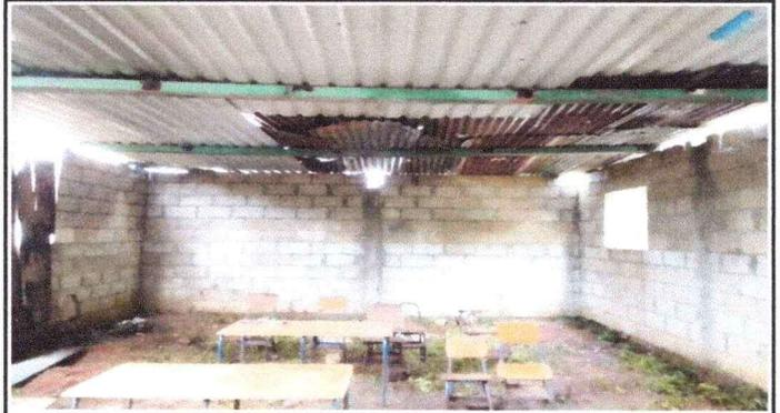
Foto 2: Cambio de laminas acanalada a troquelada calibre 26.
