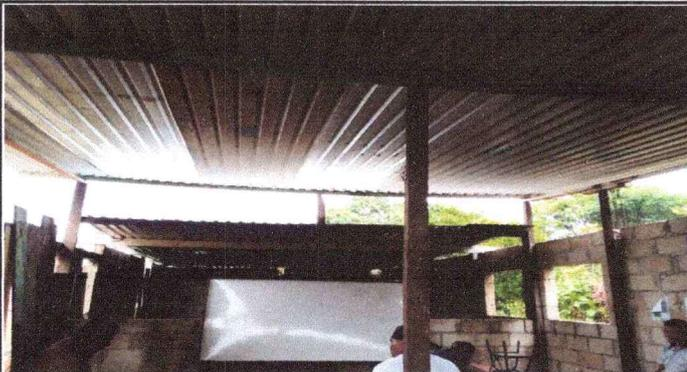
Foto 3: Sustitución costaneras de madera a metal.
